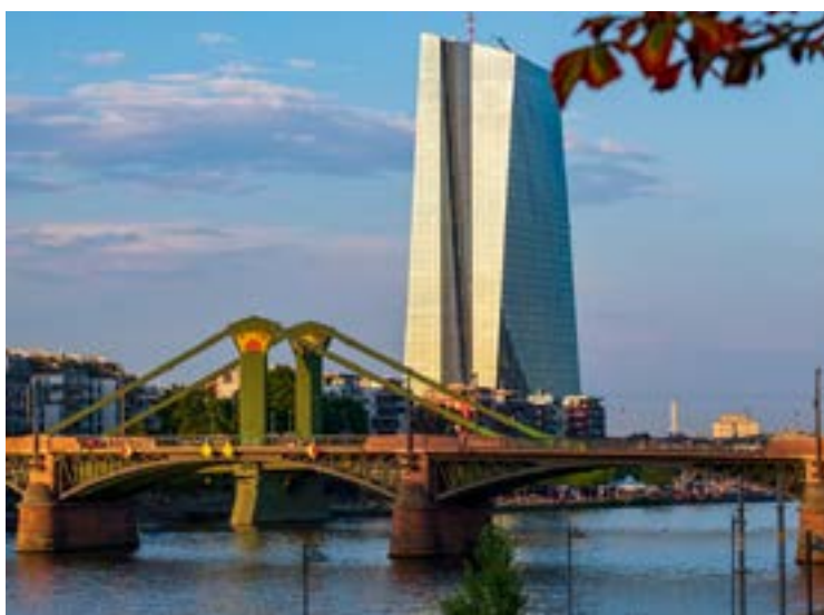
Francoforte sul Meno, Banca Centrale Europea
